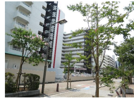
▲A棟北側前面道路
