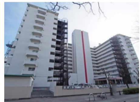
▲A棟北側建物外観
