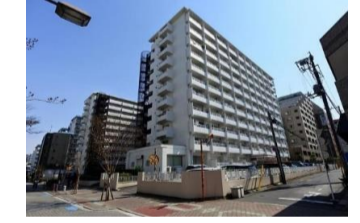
▲A棟西側建物外観
