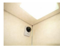
▲EV内防犯カメラ
