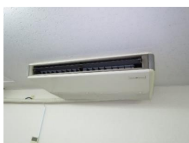
▲大型エアコン
