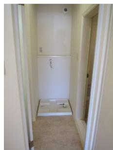
▲B棟防水パン (新設)
