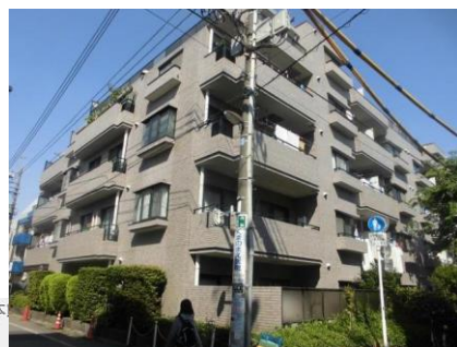
▲建物外観（タイル貼り）
