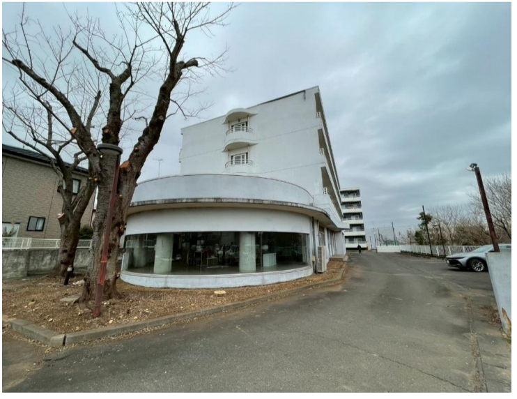
▲建物外観(南側)
