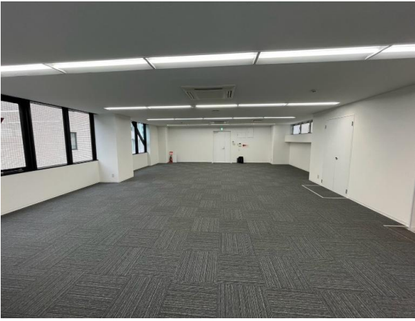
▲西側窓際から撮影
