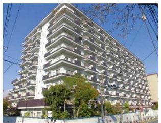
↑堂々たる建物外観
